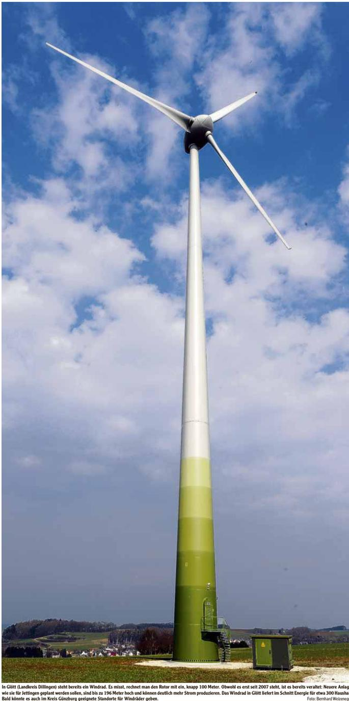
In Glött (Landkreis Dillingen) steht bereits ein Windrad. Es misst, rechnet man den Rotor mit ein, knapp 100 Meter. Obwohl es erst seit 2007 steht, ist es bereits veraltet. Neuere Anlagen, wie sie für Jettingen geplant werden sollen, sind bis zu 196 Meter hoch und können deutlich mehr Strom produzieren. Das Windrad in Glött liefert im Schnitt Energie für etwa 300 Haushalte. Bald könnte es auch im Kreis Günzburg geeignete Standorte für Windräder geben. Foto: Bernhard Weiseger
